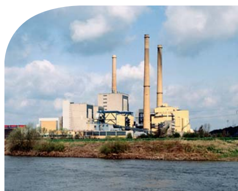
Gemeinschaftskraftwerk Veltheim (GKV), Photovoltaik-Anlage der Stadtwerke Bielefeld auf der SchücoArena, Heizkraftwerk (HKW) an der Schildescher Straße (v. l.)
