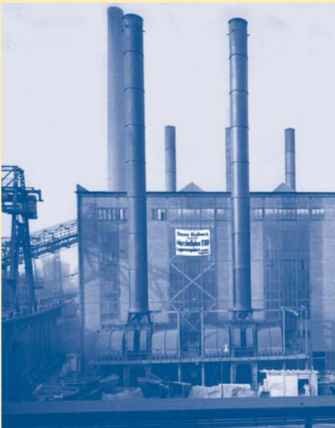
Wieder aufgebautes Kraftwerk, 1951
